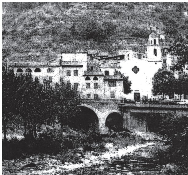
La frazione di Torri
